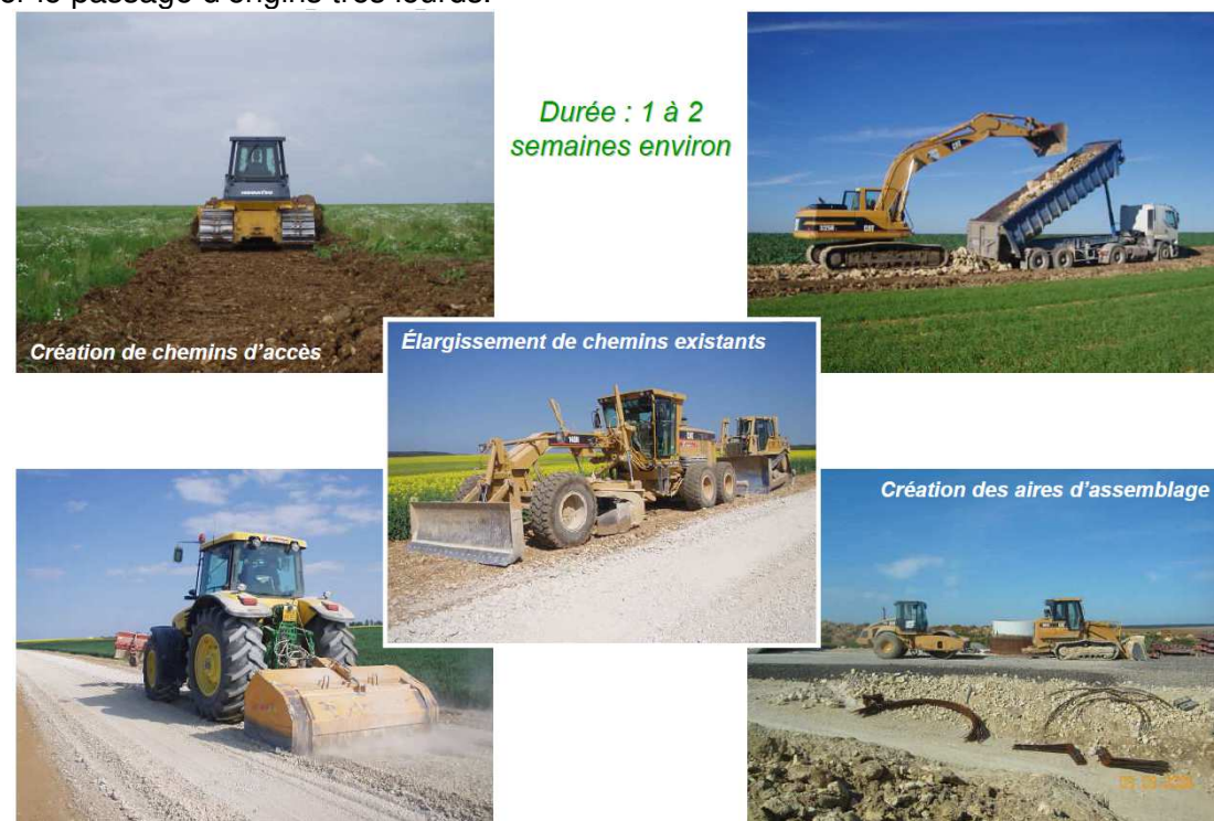
Illustration 53 : phases d'aménagement des nouvelles pistes d'accès
